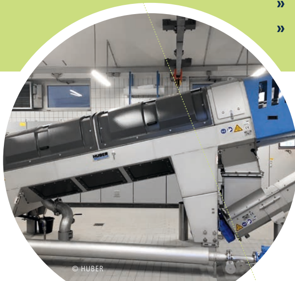
Mithilfe der HUBER Schneckenpresse Q-PRESS® wird Klärschlamm entwässert
